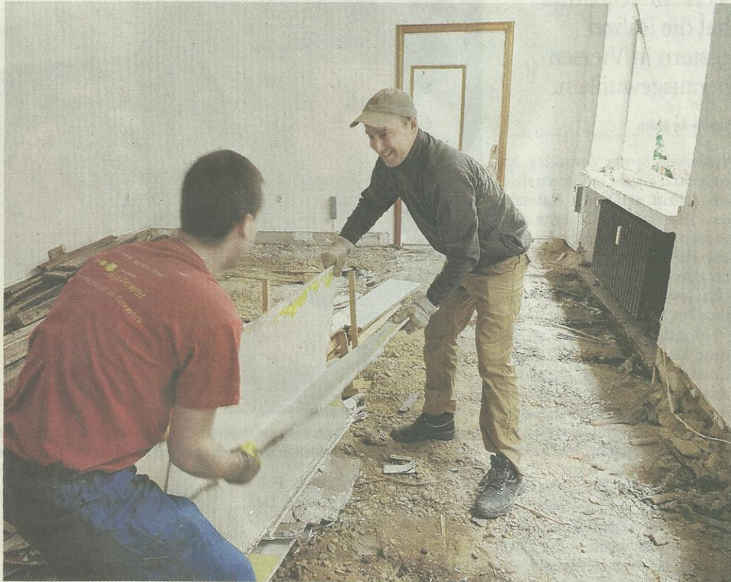
Sanierungsarbeiten im Haus der Seidenkultur: Die Probleme und die damit verbundenen Kosten für die Erneuerung der Statik des Hauses sind noch unklar. Fotos: Dirk Jochmann, Andreas Bischof
